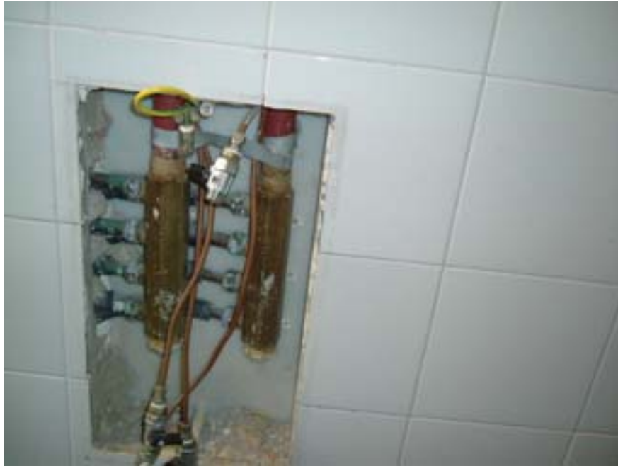
Fig. 2 - Collegamento equipotenziale in un bagno
