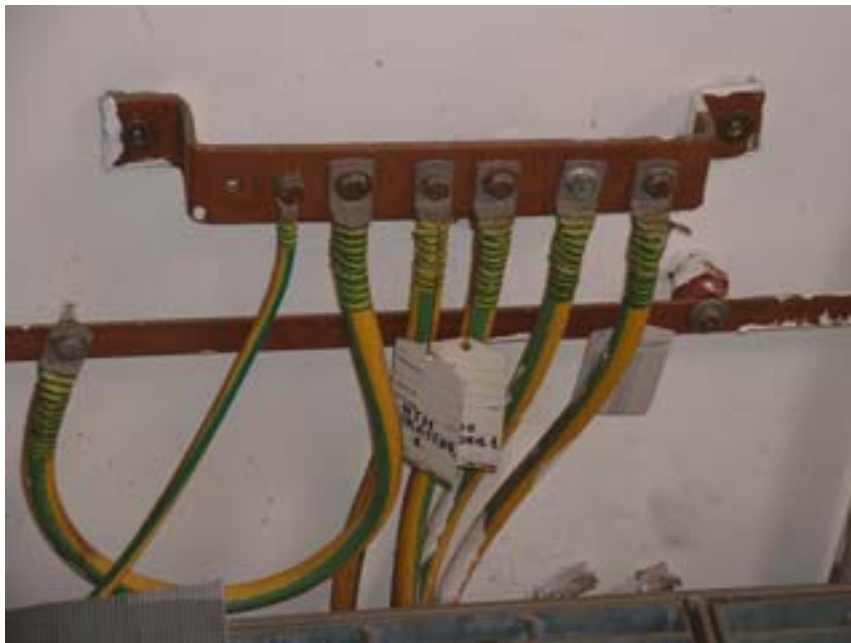
Fig. 4 - Barra equipotenziale
