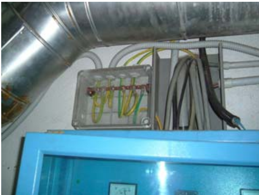
Fig. 3 - Collettore equipotenziale
